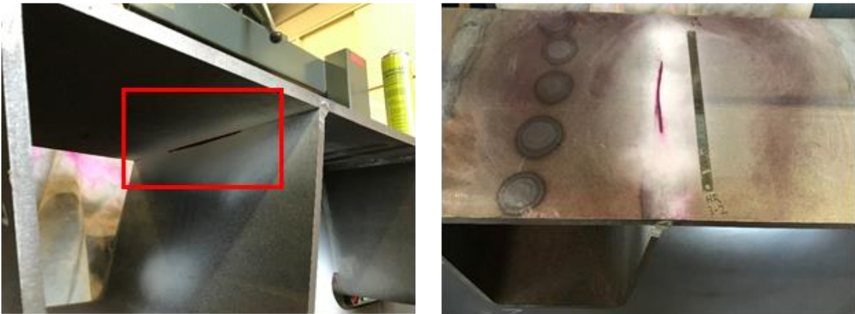
Abbildung 79: Rissausgangsort Längsrippe - Deckblech (Schweißnahtwurzel äußerer LR-Steg)
