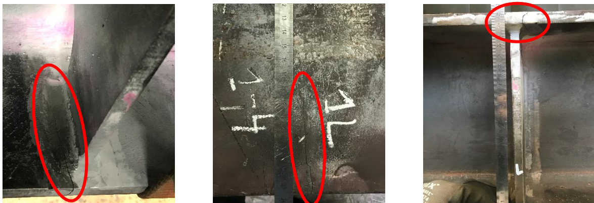
Abbildung 83: Ermüdungsriss, wahrscheinlich aufgrund eines Flankenbindefehlers
