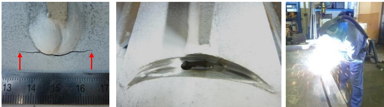
Abbildung 5: Ermüdungsanriss an Längssteife (links), Ausschleifen des Anrisses (Mitte) und Reparaturschweißen (rechts) [6]
