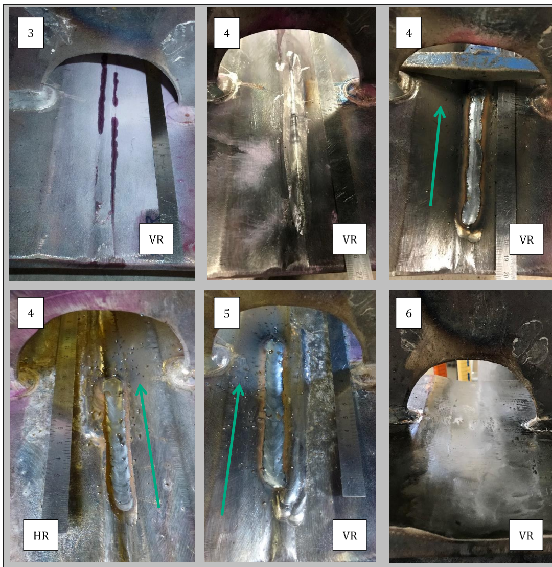
Abbildung 78: Instandsetzung Großbauteil Typ 2 - 1 Stumpfnah rechts (Pfeil = Schweißrichtung)
