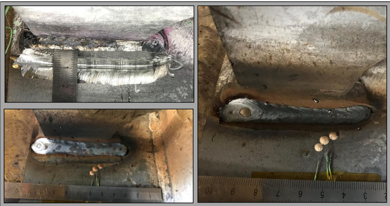
Abbildung 73: Schweißnahtvorbereitung und oberseitige Reparatur der Steife 5R 1 – 5 S960QL
