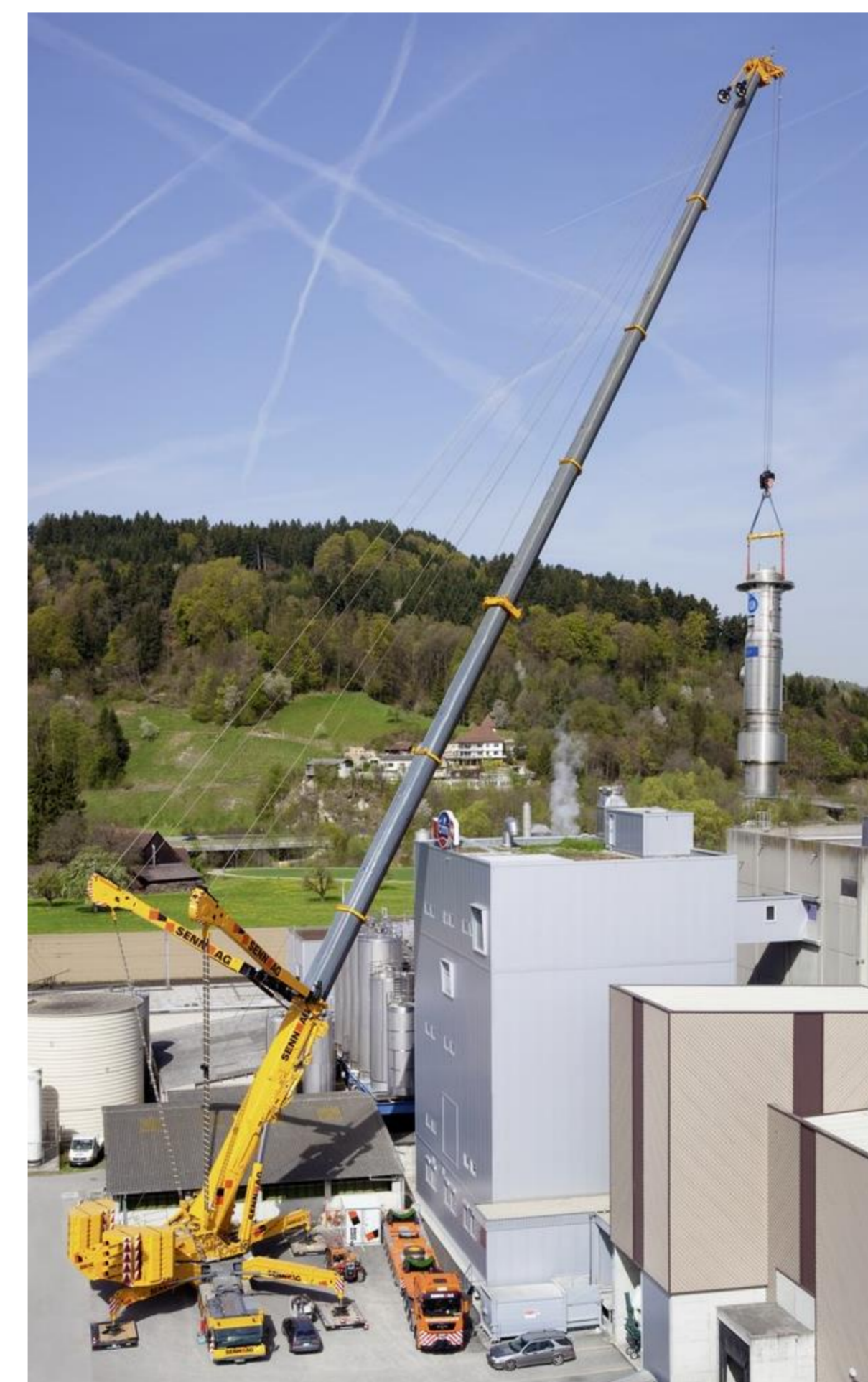
Bild: Liebherr Werk Ehingen GmbH
